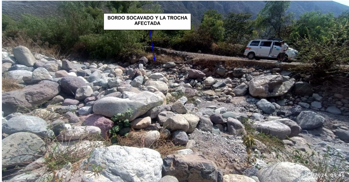
FIGURA N°03: TRAMO MARCAYJO CON BORDOS EROSIONADOS, PONIENDO EN PELIGRO A LA UNICA TROCHA CARROZABLE PARA ACCESO A LAS 22.3 HA DE AREAS DE CULTIVO
