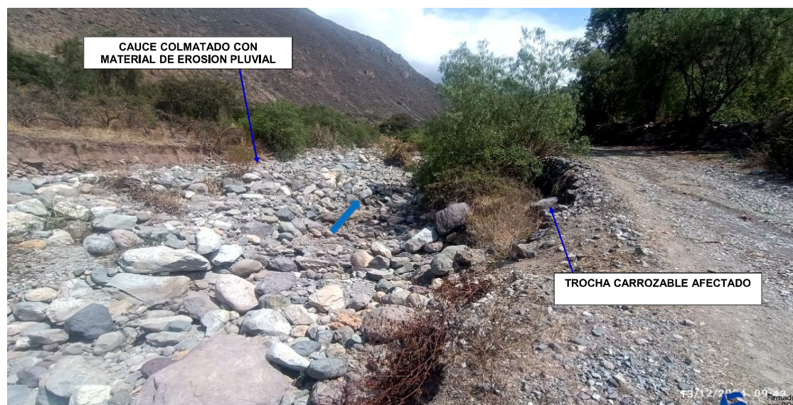
FIGURA N°02: CAUCE COLMATADO CON FLUJO DE DETRITOS Y ROCAS DE DIFERENTES TAMAÑOS DE LA QUEBRADA LAMPIAN, SECTOR MARCAYJO, DISTRITO DE LAMPIAN, PROVINCIA DE HUARAL - LIMA.
